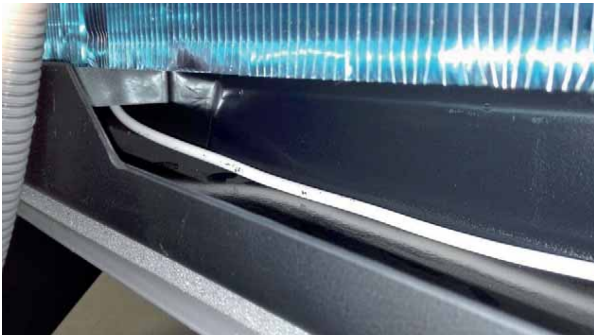
Obr. 2 – Protažení topného kabelu sběračem kondenzátu
